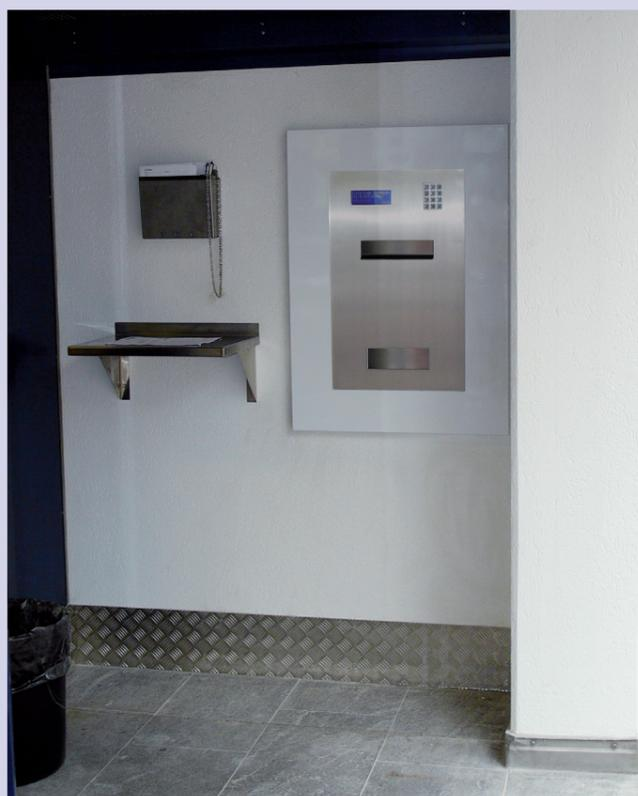
Bei Niveaudifferenz im Innen- und Aussenbereich wird der Sockel des Tresors in der Höhe entsprechend angepasst, damit das Display an der Aussen Bedieneinheit auf einer angenehmen Höhe von 1.5 Meter ab Boden abgelesen werden kann.
